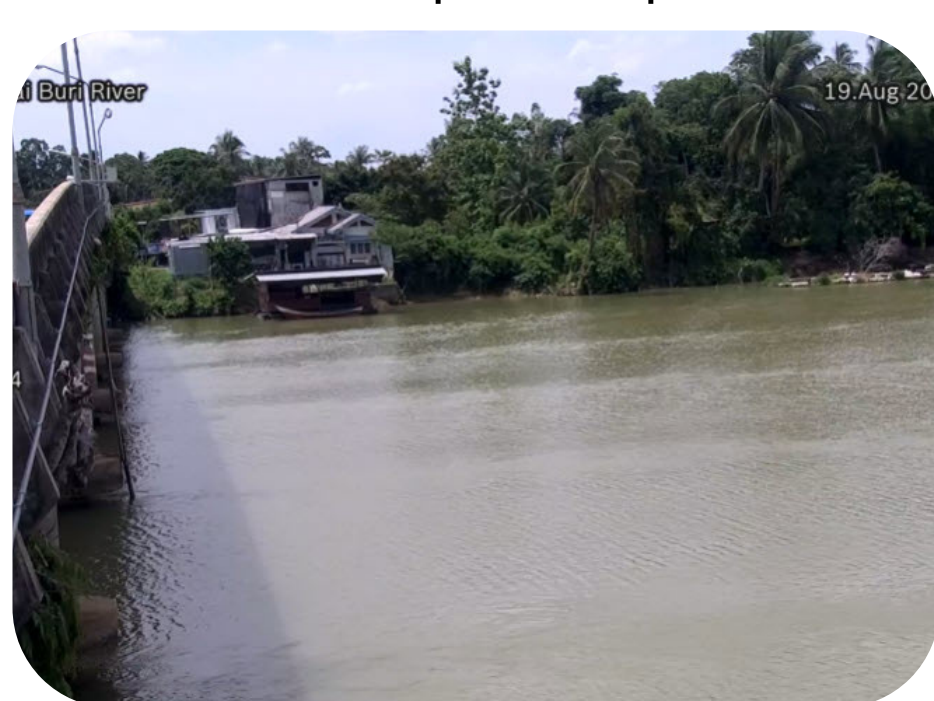
4157-แม่น้ำสายบุรี อ.สายบุรี จ.ปัตตานี
